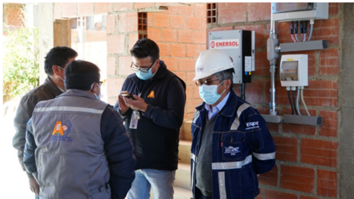
Inspección a sistema de generación distribuida, El Alto.
