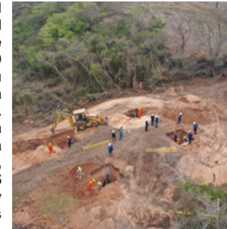
Sitio de construcción - Línea de transmisión
