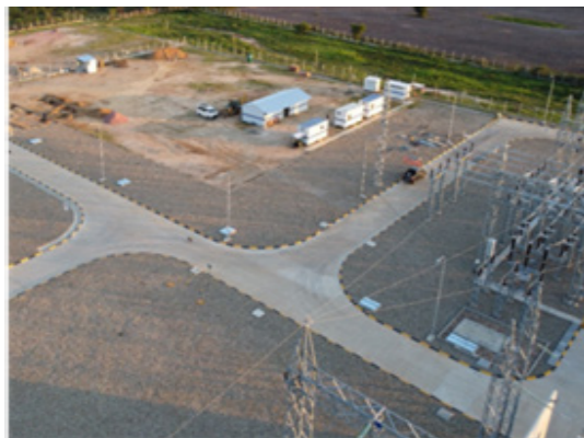
Sitio de Construcción de la Bahía de Transformador 115 kV - Subestación Paraíso
